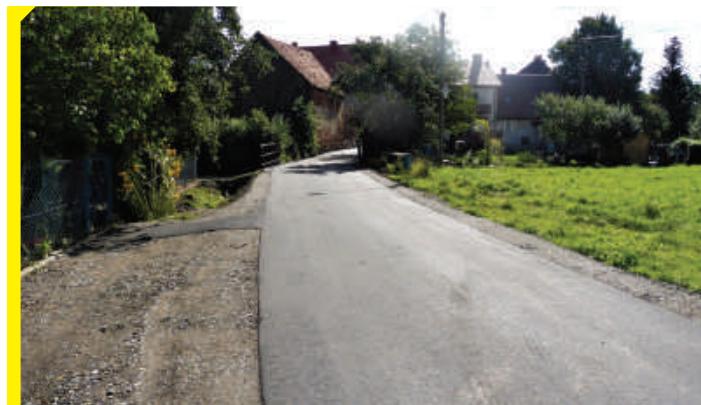
Nowa nawierzchnia została wykonana na odcinku o długości 0,2 km
